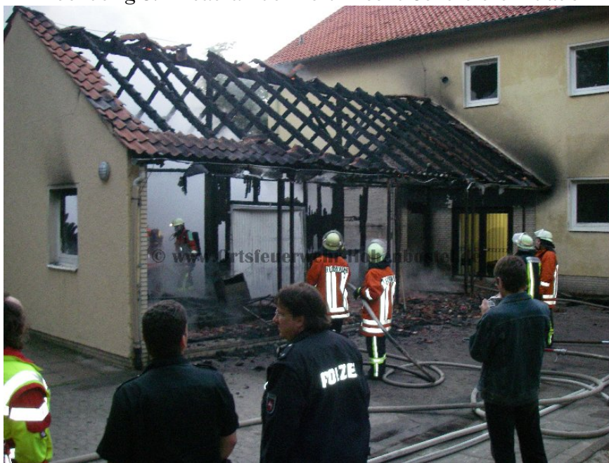
Abbildung 3: Anbau an der Bert-Brecht-Schule brennt aus
