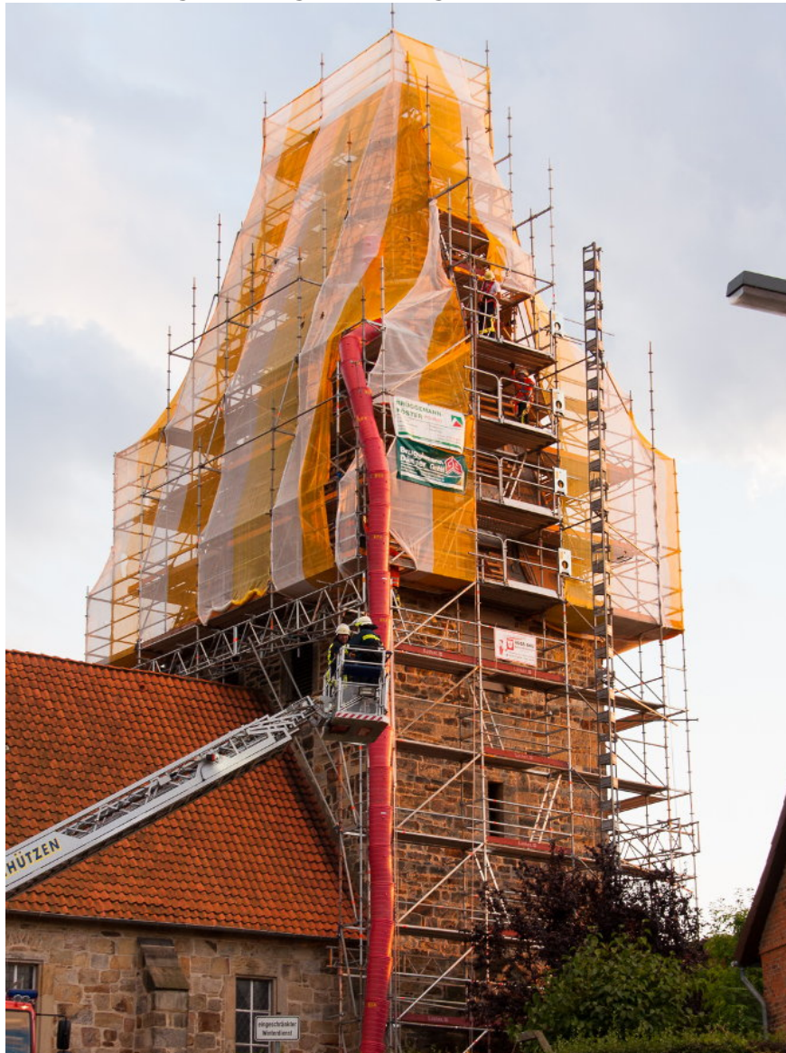
Abbildung 2: Übung an der eingerüsteten Thomaskirche
